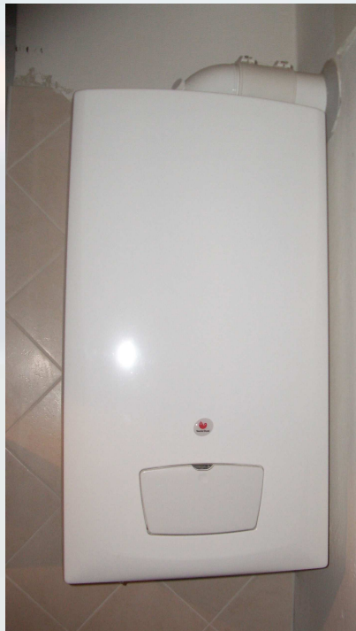
Impianto di combustione a Metano 25-30 kW(t)
