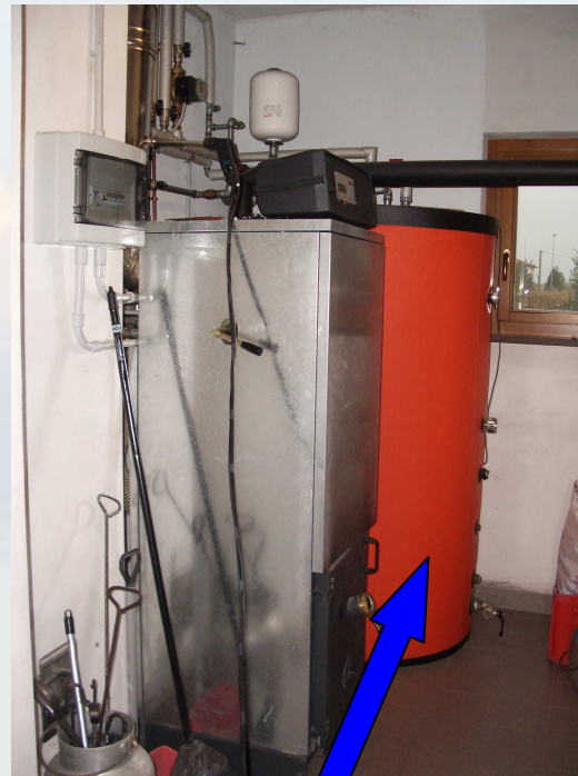
Impianto di combustione a Mais Granella 25-30 kW(t)
