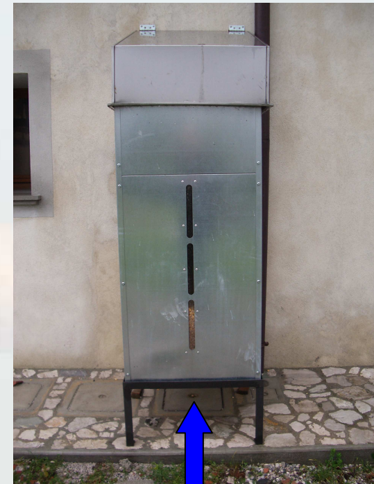
Impianto di combustione a Mais Granella 25-30 kW(t)
